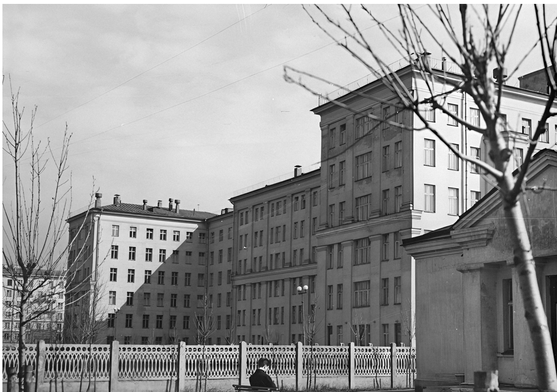
Рис. 38. Объединенная больница № 2 Московского района [61]
